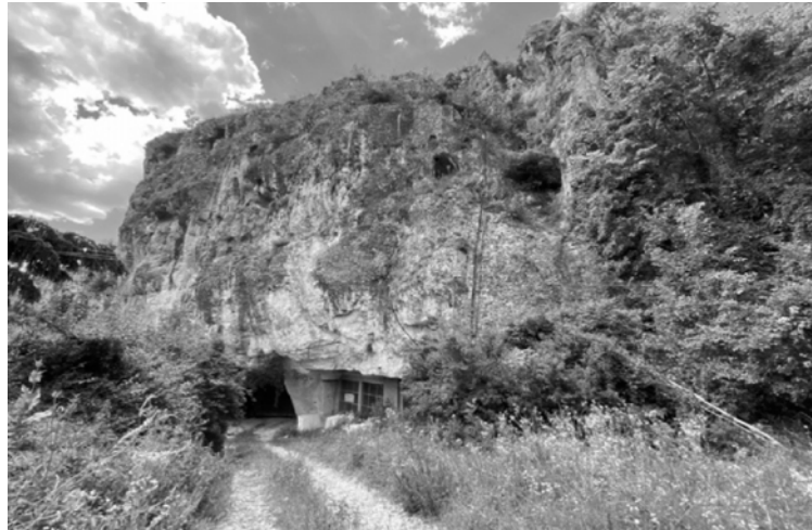
Фиг. 2. Входа на подземният рудник за добив на скални блокове "Изгорелица"
